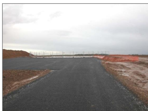
Photo 3 : Zone de grutage aménagée ou plateforme, parc éolien de Saint-Léger (Source : EUROWATT)
